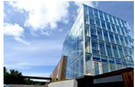
2011 年 9 月に工場と事務所棟を新設。事務所棟は「エコハウス棟」と呼ばれ、太陽光発電、地中熱ヒートポンプ、雪冷房システムなど 70 項目の環境技術を導入し、CO2 排出量 50%削減を達成しています。
